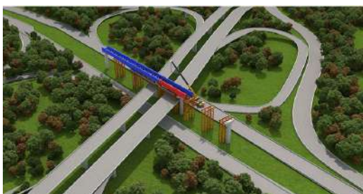
8) 小里程方向中跨节段平纵联、横梁吊装，同第三步。
