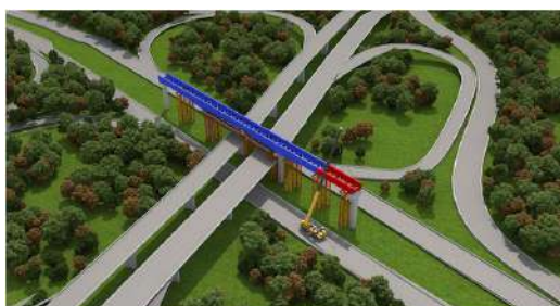
10) 小里程方向边跨节段吊装
