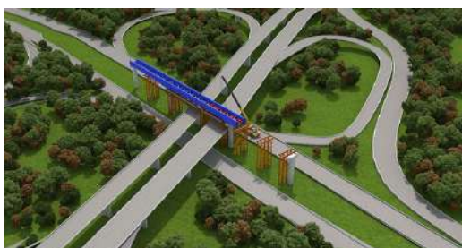
9) 小里程方向边跨节段吊装，同第四步。
