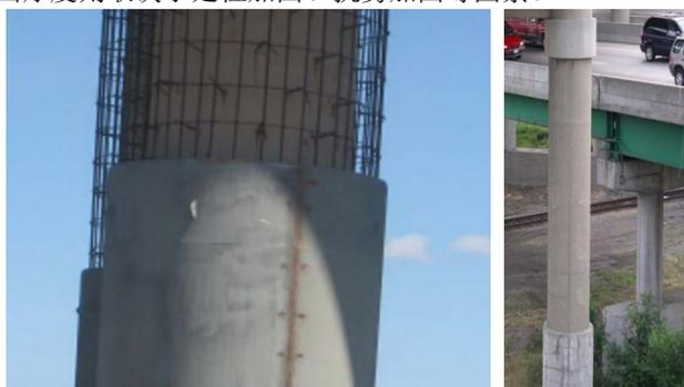
图1 圆形墩外包混凝土加固
