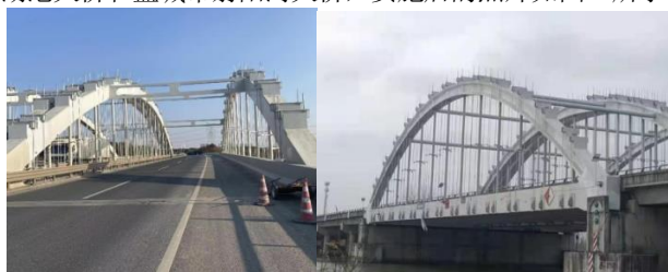
无锡市G312直湖港大桥
