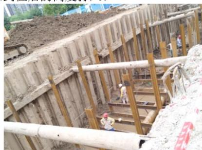
图4 钢板桩施工
