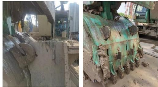
图11 刷壁器连接组件
