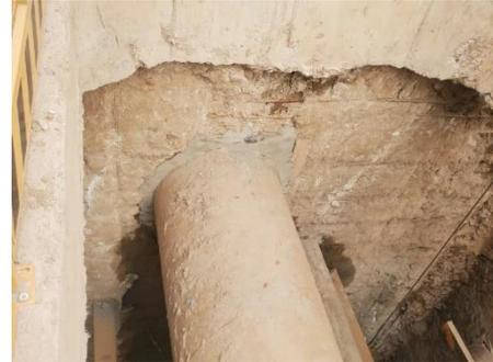
图6 管道与检查井连接填充
