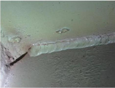
图 2 13-14 线/C 轴吊车梁上翼缘与加劲肋连接焊缝开裂
