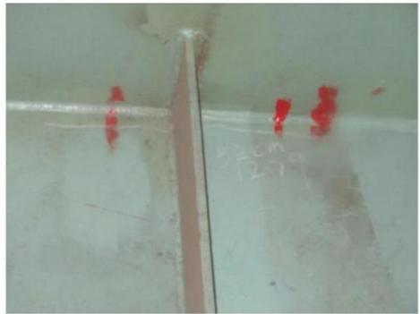
图 4 8-9 线/D 轴吊车梁上翼缘与腹板、加劲肋连接焊缝开裂，长度 520mm
