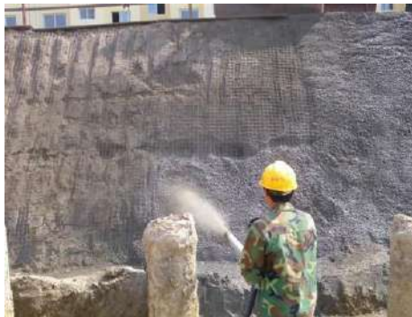
图 7 喷射混凝土
