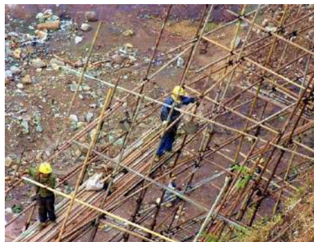
图 8 双排脚手架搭设
