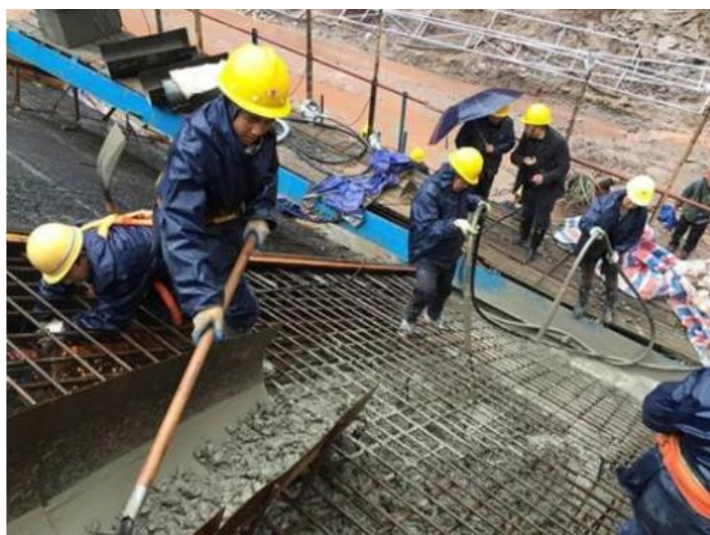
图1 现场浇筑技术
