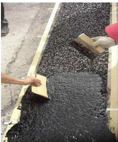
图1 填充式伸缩缝
