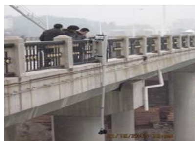
图4 使用智视系统进行桥梁检测
