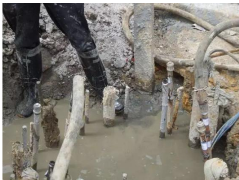
图1 桩端后注浆施工的现场情况
