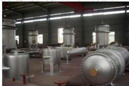
图1 热处理在压力容器应用的施工现场
