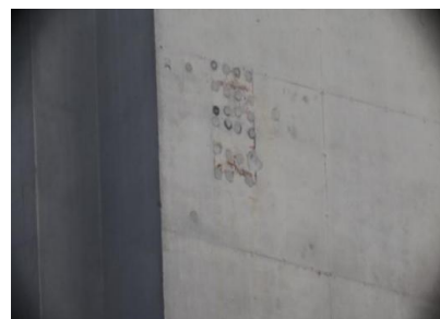
图 15 塔内立面 12#节段近 11# 节段 0.5m 距左侧 0.2m 钢板锈胀
