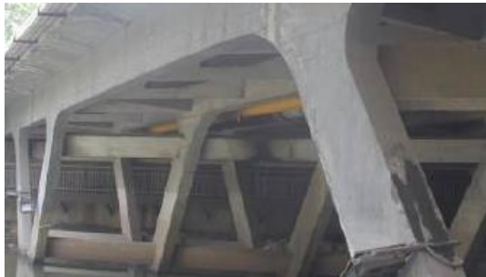
图3 桥梁现状图（一）
