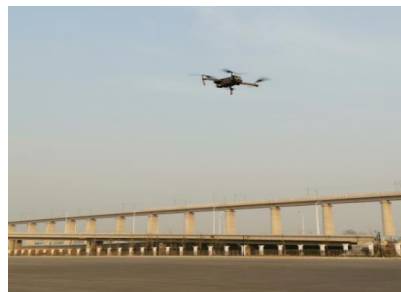
图2 使用无人机进行桥梁检测
